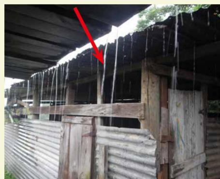
Concentration de flux des eaux pluviales par les tôles d'un hangar
